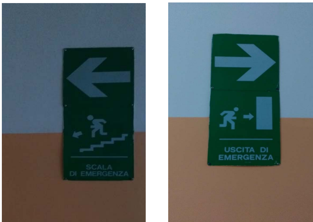
Foto 4, 5 – Segnaletica via di esodo
